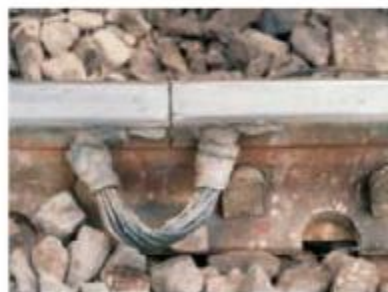
▲ Jama de dilatación en rieles de ferrocarril.
